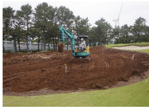
既存グリーン撤去・造形
