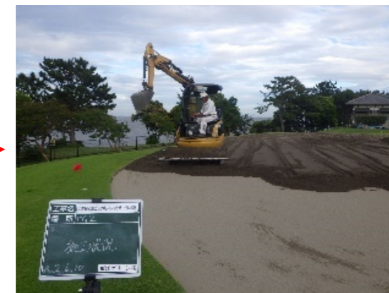
グリーン砂敷き均し
