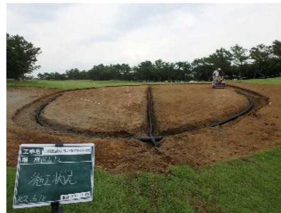
グリーンの暗渠敷設
