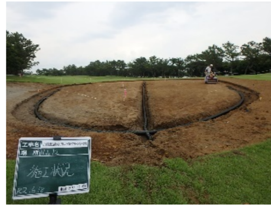
グリーンの暗渠敷設
