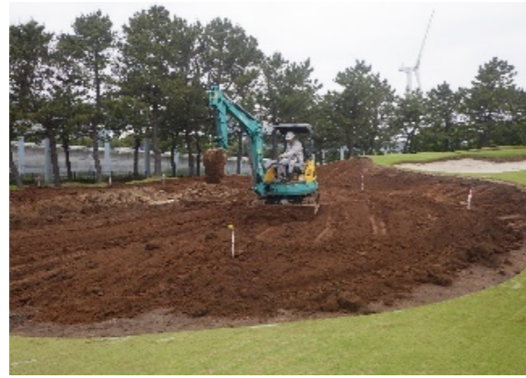
既存グリーン撤去・造形
