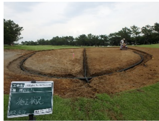
グリーンの暗渠敷設
