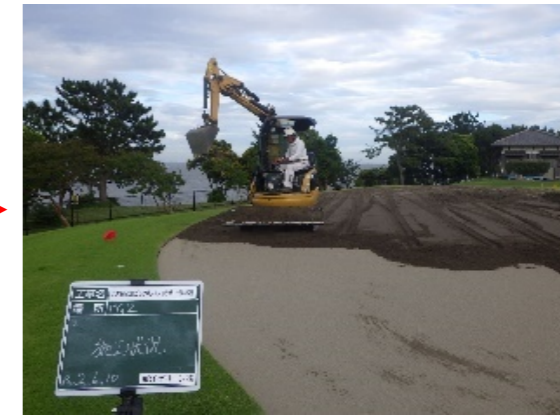
グリーン砂敷き均し
