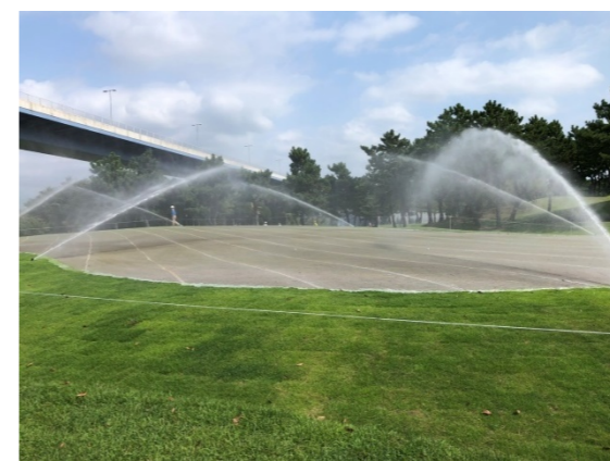
養生管理作業 散水
