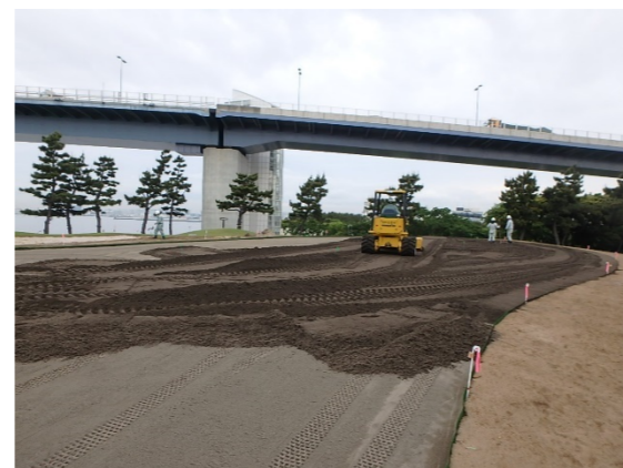
基盤碎石・砂敷き均し
