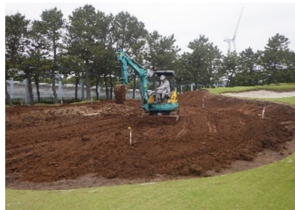
既存グリーン撤去・造形
