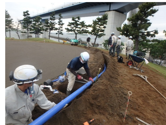
スプリンクラー・配管敷設
