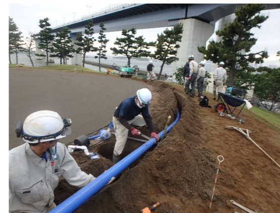
スプリンクラー・配管敷設
